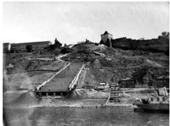
Строительство Чкаловской лестницы
